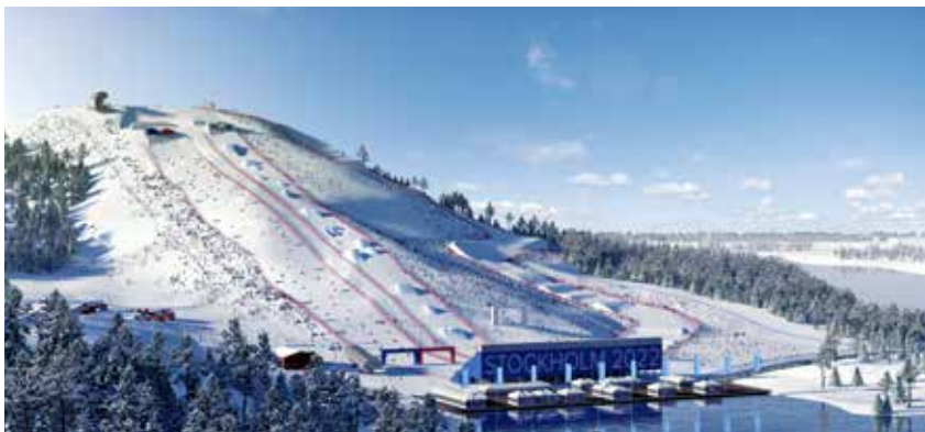
Flottsbrobacken var tänkt för slopestyle, skicross och parallellslalom. Med hjälp av schaktmassor skulle backen göras högre och längre. Schaktmassor från stora byggprojekt i Stockholmsområdet skulle användas här. Massor som kunde användas här i stället för att tippas långt utanför länet.
